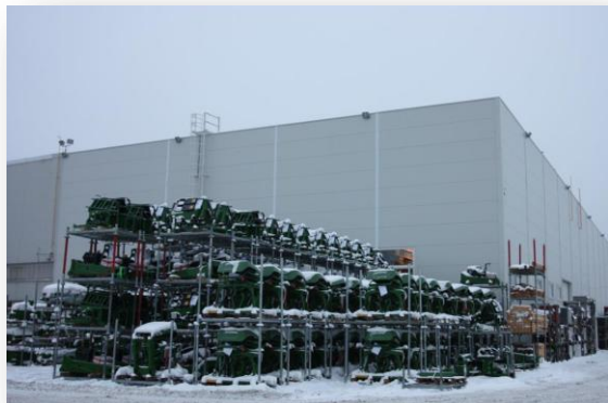
Новый производственный корпус
